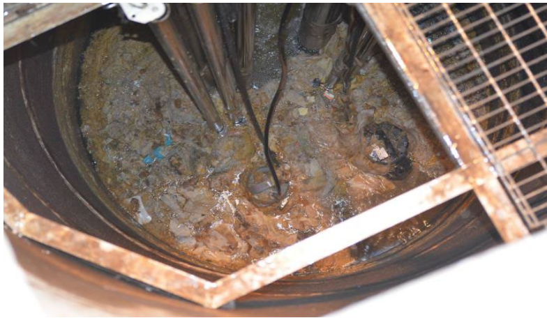
Testinstallasjon før Concertor
