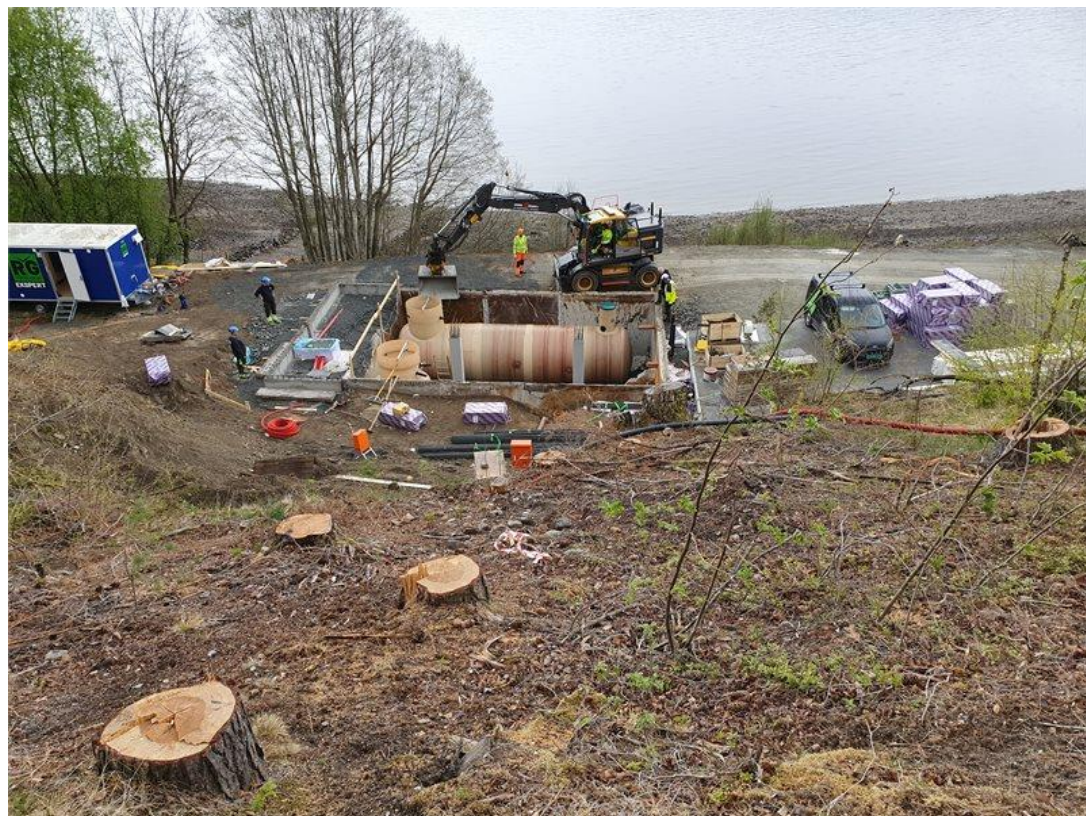
Mottakstank og pumpesump
