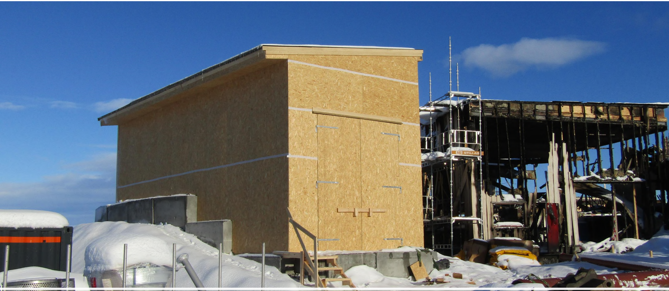
Hus for innløpsrist
