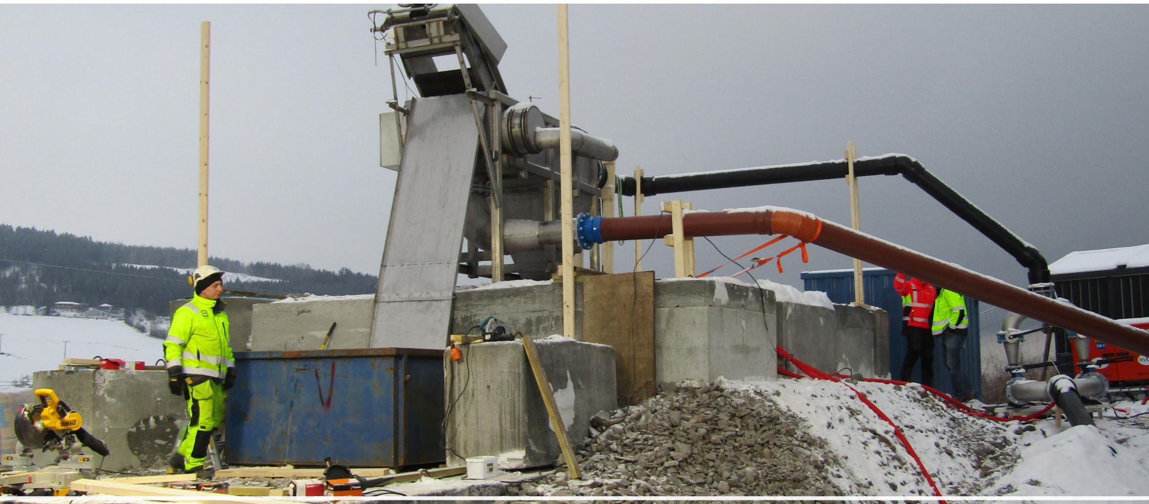
Innløpsrist. Montert opp på en pukkfylling
